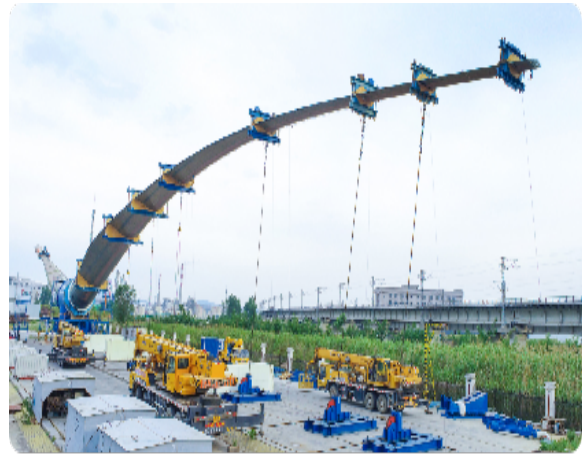
20MW 超大型风电叶片全尺寸结构测试平台
